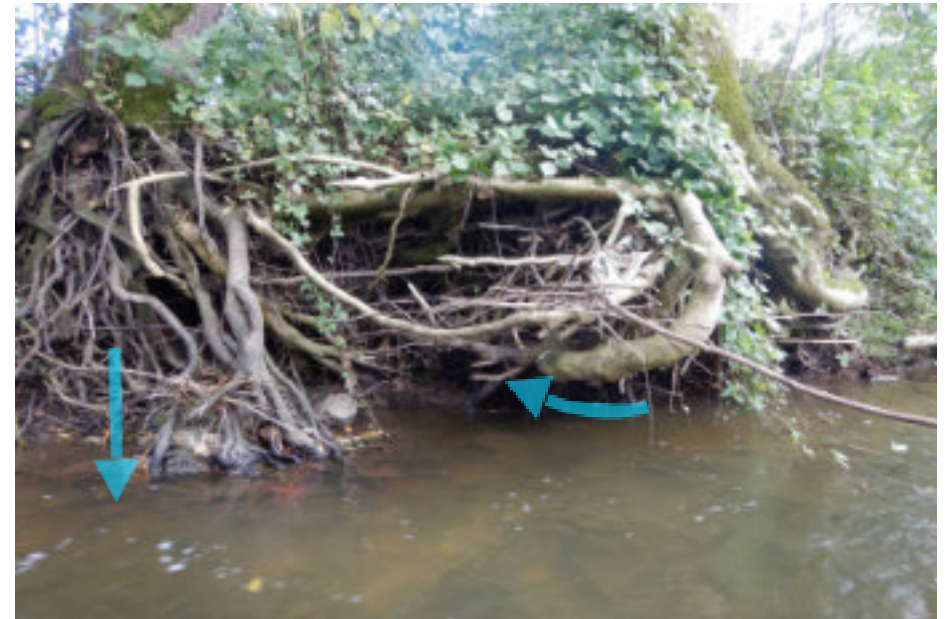
Foto: extrasă din Hermannsdorfer Georg, „Renaturierung von Fließgewässern. Praxis Handbuch für naturnahe Bauweise“, 2020.
