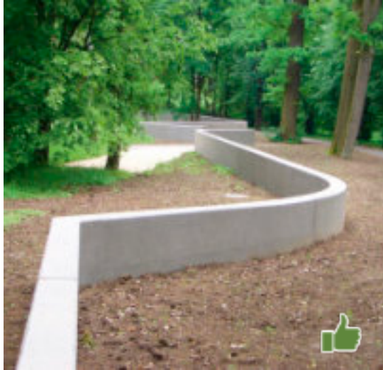
Fotografia arată un exemplu de zid de apărare amplasat la distanță față de râu, ce poate fi element decorativ în spațiu sau zonă verde.
