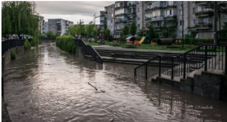
Folosințe pe mai multe niveluri, la cote ridicate ale apei, după amenajare de accesibilizare a apei. Canalul Morii, Reghin, județul Mureș.
