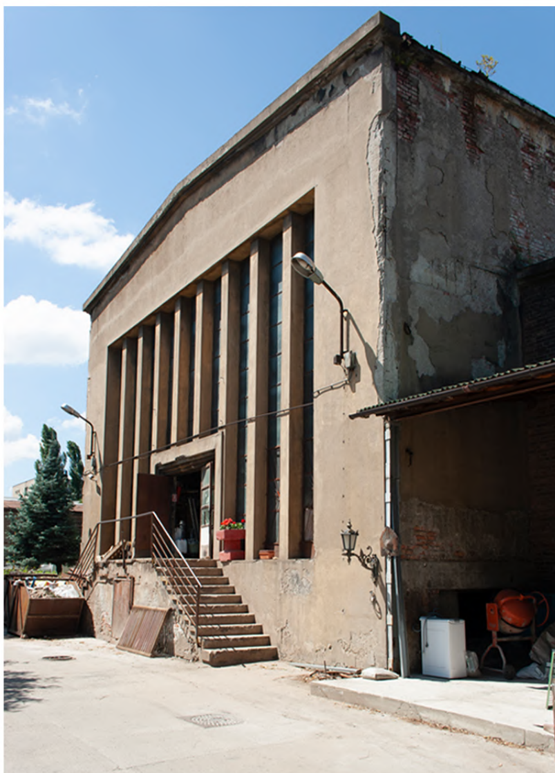
Clădire parte din ansamblul Carbochim care, conform proiectului pentru construcția viitorului mall, va fi demolată.
