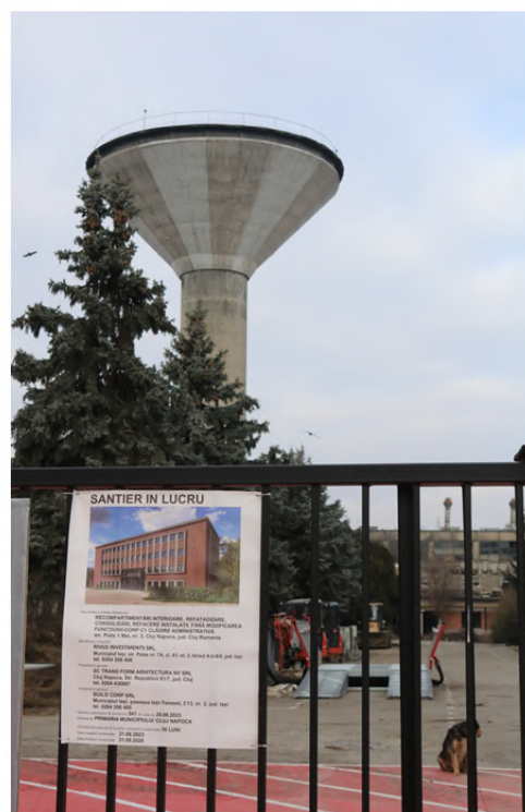
Șantier în lucru © Simona Or-Munteanu
